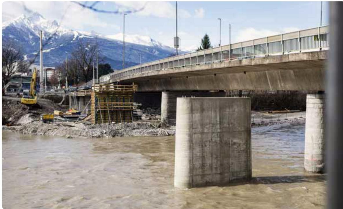
Die neue Grenobler Brücke: Der Bau der Brückenpfeiler wird gerade finalisiert, im Sommer wird das Tragwerk aufgesetzt.
